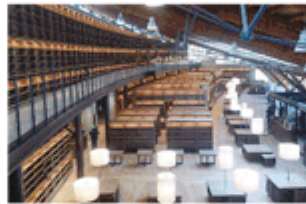
図書館内装工事
