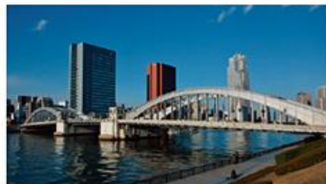
耐震補強後の勝間橋
