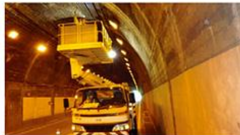
トンネル点検
