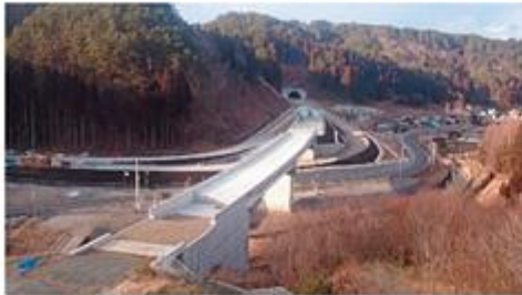
三陸沿岸道路建設
