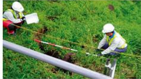
熊本地震での地すべり観測
