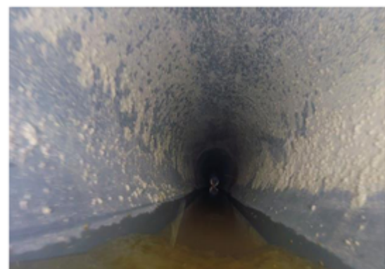
閉鎖環境 (下水道) 点検ドローンからの撮影画像
