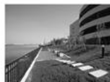
屋上や外壁、敷地内の積極的な緑化を実施
