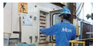
凝集沈殿処理制御装置
