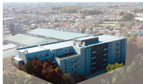
関東主管センター
