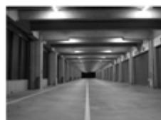
館内照明器具をLED化し、温室効果ガス排出量の削減を実現
