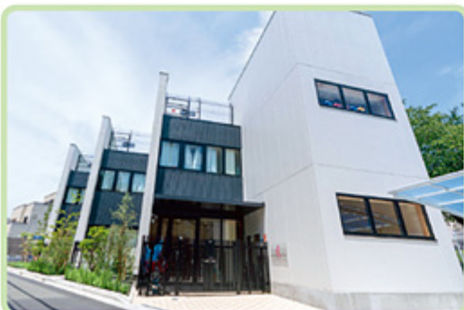
さくらさくみらい武蔵小山 借地スキーム活用事例
