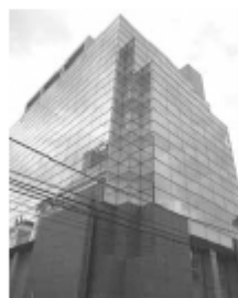
墨田区 収益ビル
