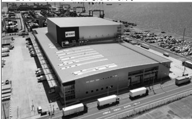
六甲アイランドDC外観
