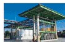
混合エマルジョン化施設
