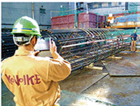
杭施工記録の様子
