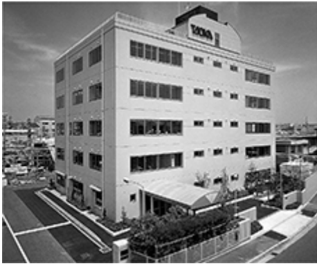
事務研究棟（大阪市淀川区）
