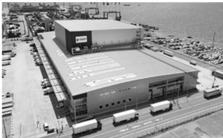
六甲アイランドDC外観
