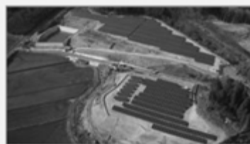
S-28 茨城常陸大宮太陽光発電所
