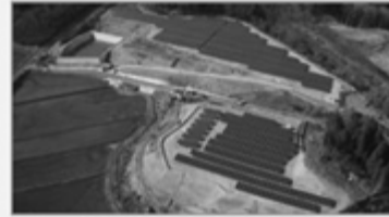
S-28 茨城常陸大宮太陽光発電所
