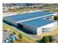
日本通運 駒ヶ根物流センター
