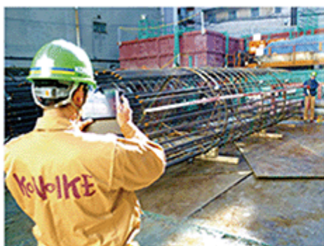
杭施工記録の様子
