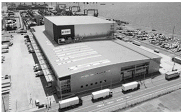
六甲アイランドDC外観
