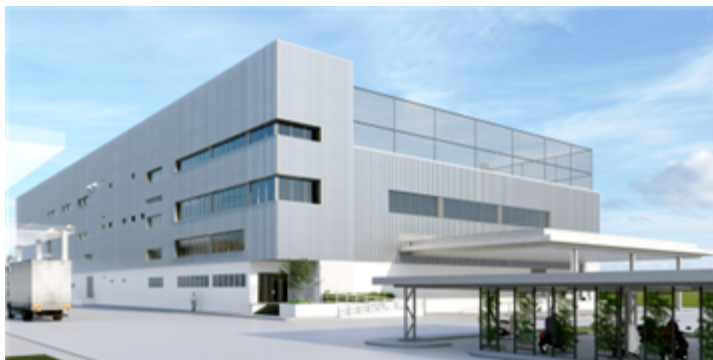
アズビルプロダクションタイランド新工場棟（2024年春竣工予定）
