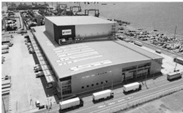
六甲アイランドDC外観
