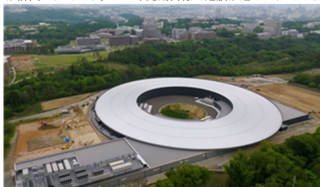
図4 建設中のNanoTerasu（ナノテラス）：東北大学 ホームページより
