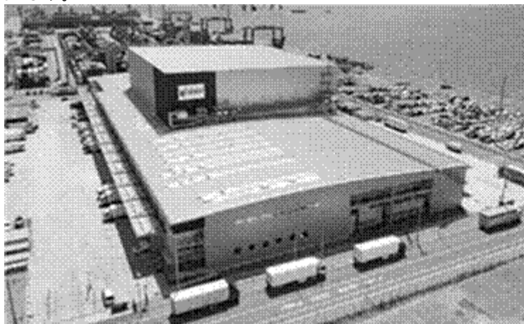
六甲アイランドDC外観
