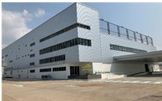
タイ生産子会社の新工場棟
