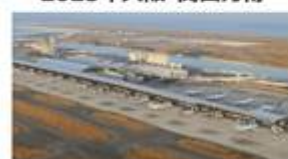
関西国際空港のリノベーション
