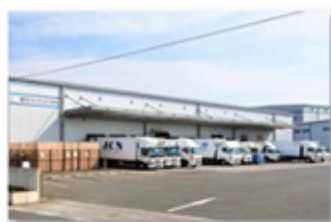
鳥栖ロジスティクスセンター
