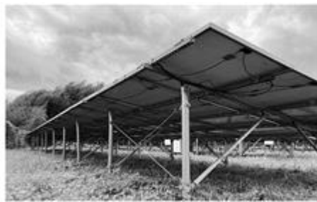
栃木 河内郡上三川町発電所 両面パネルへの入替え・反射シートの設置前
