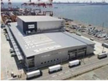
不動産のデジタル証券 ～神戸六甲アイランドDC～ （譲渡制限付）
