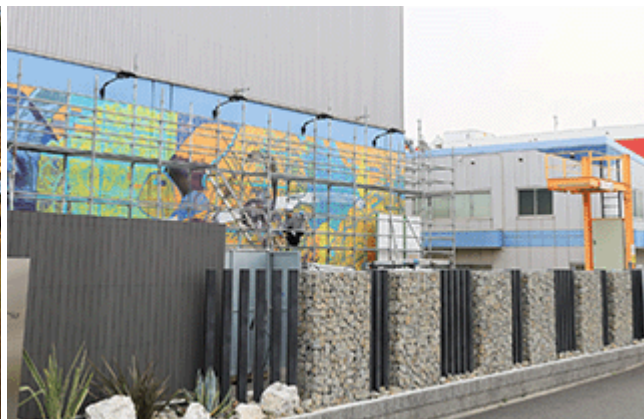
企業施設リフォーム工事
