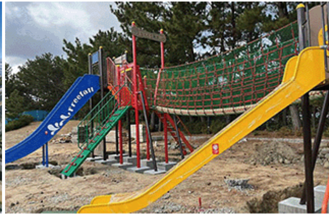
公園遊具改修工事
