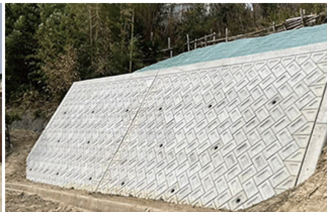
用水路災害復旧工事
