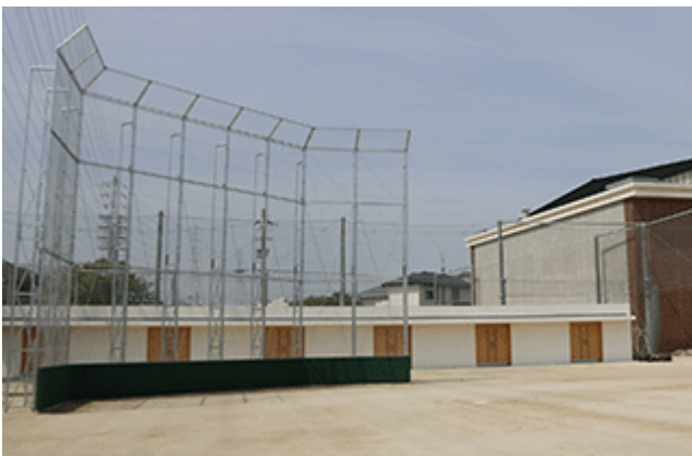
中学校屋外改修工事
