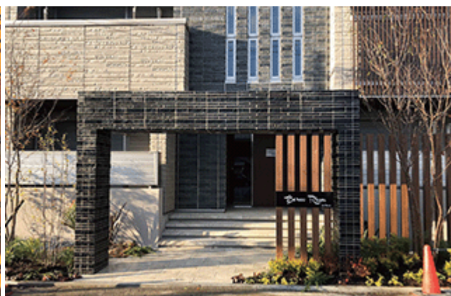
集合住宅外構工事
