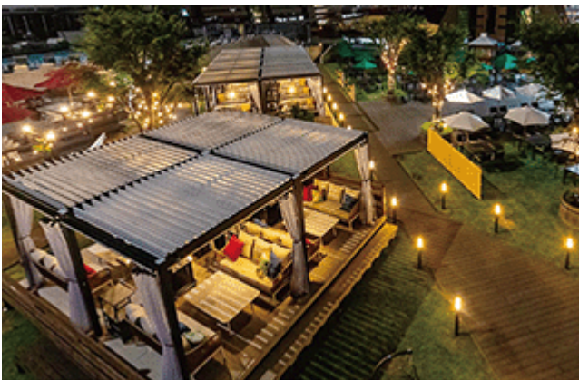
商業施設工事
