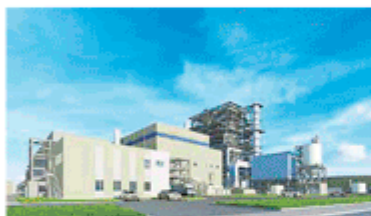
福島いわきバイオマス発電所 (112MW)
