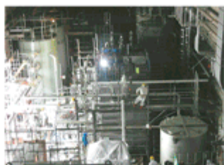
高濃度汚染水浄化設備設置工事 (廃炉工事)
