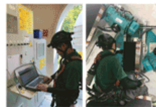
風車内で起動確認
