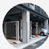
機械式駐車場
